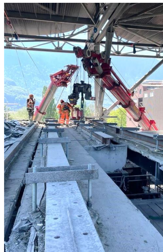
Démantèlement de l'ancienne toiture
