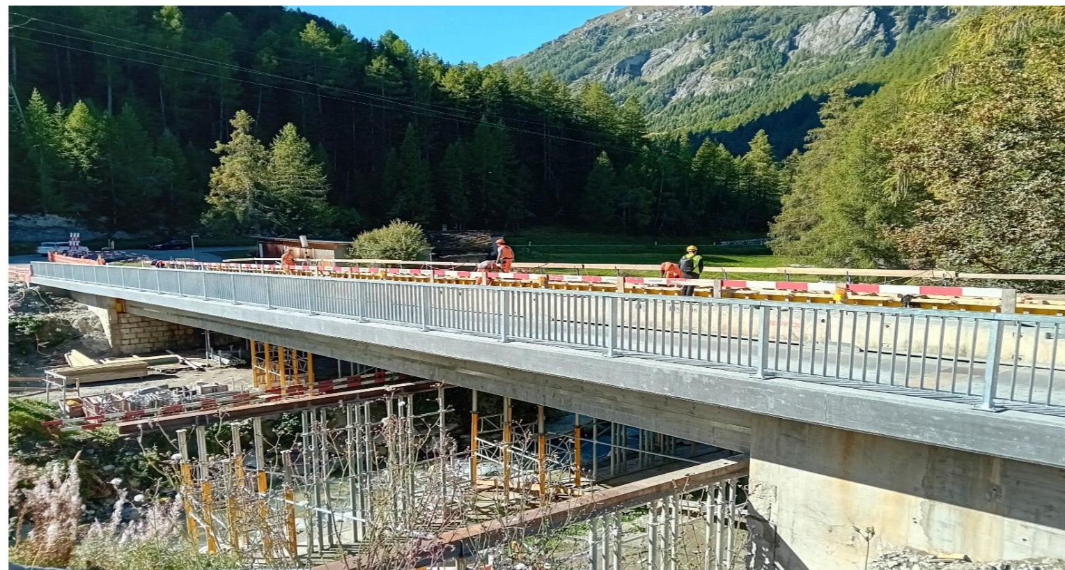
Bétonnage de la bordure aval
