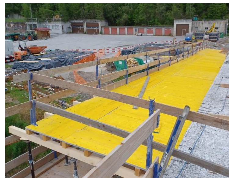
Coffrage de l'élargissement
