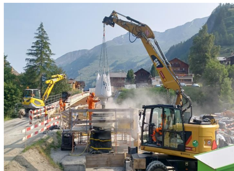
Fabrication du CFUP
