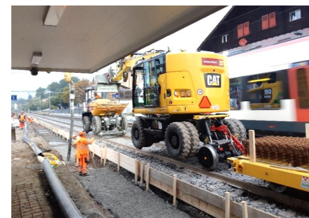
Travaux avec engins rail-route
