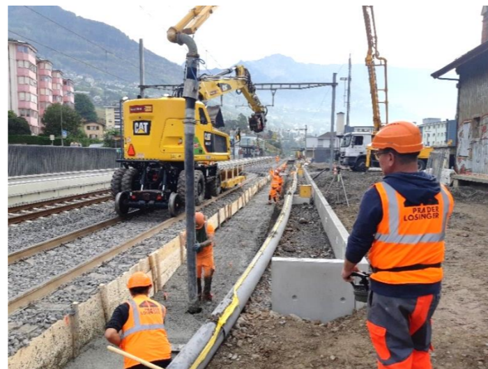
Travaux de préparation du quai
