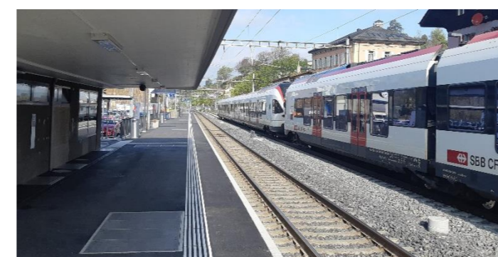
Nouveau quai n°2 en service
