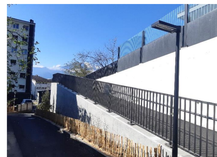
Rampe d'accès au quai n°1
