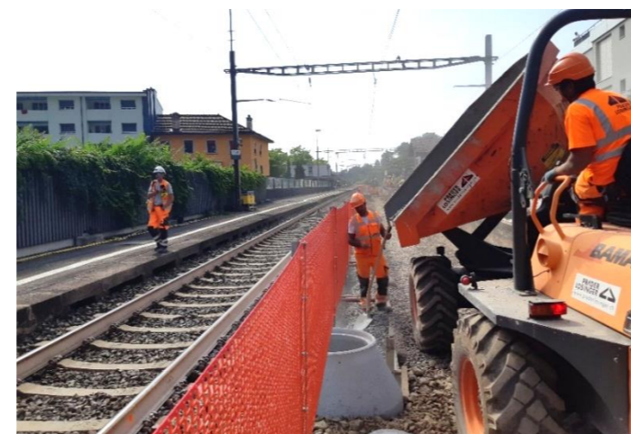
Réalisation du drainage entrevoie
