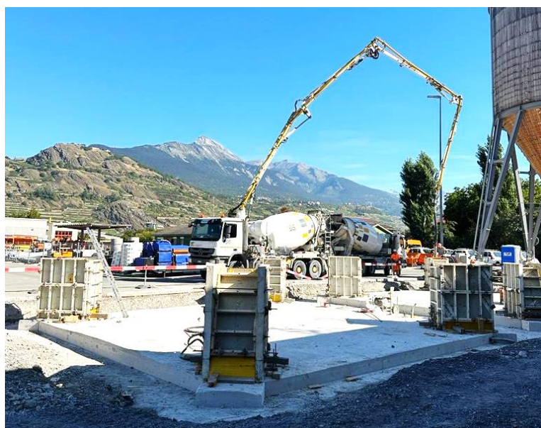
Bétonnage des socles
