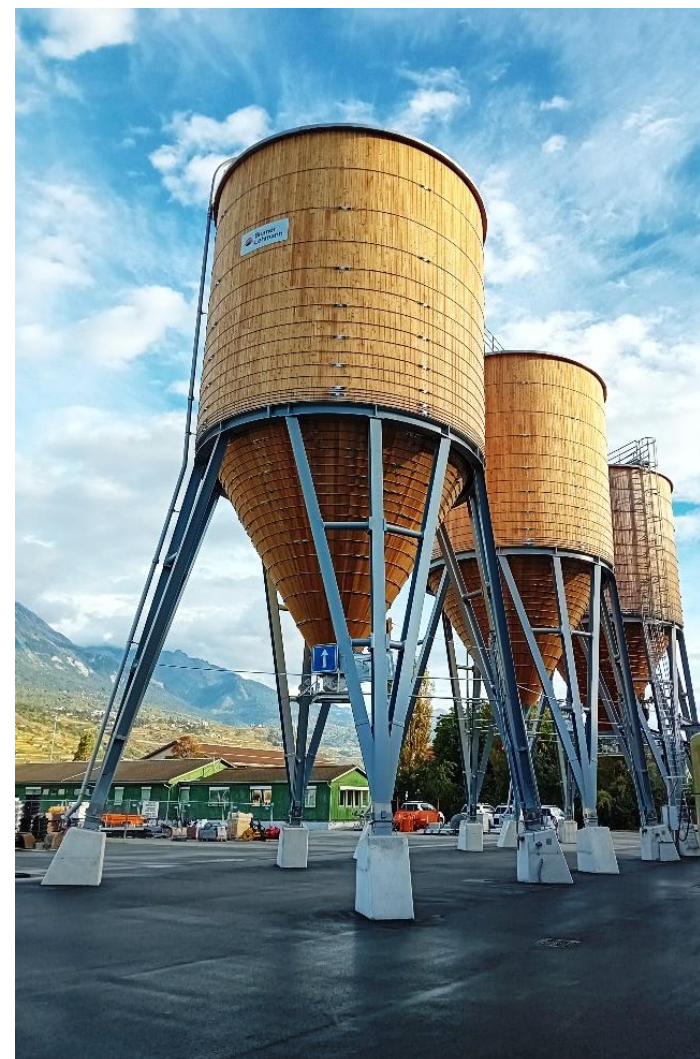
Silos à sel - Etat fini
