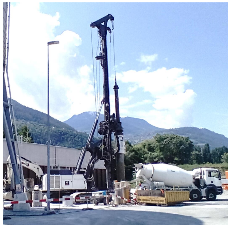
Réalisation des pieux forés
