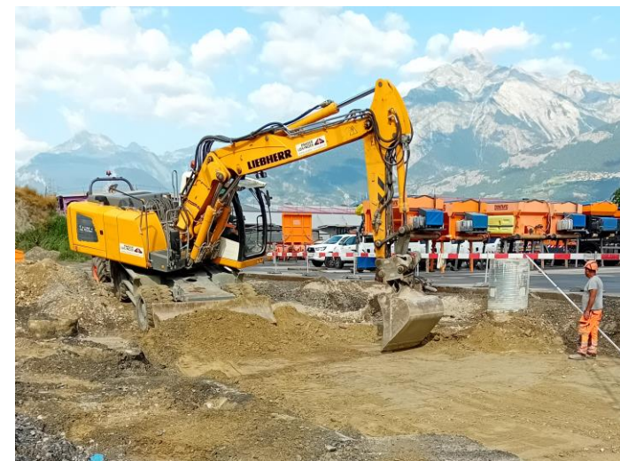
Travaux de terrassement
