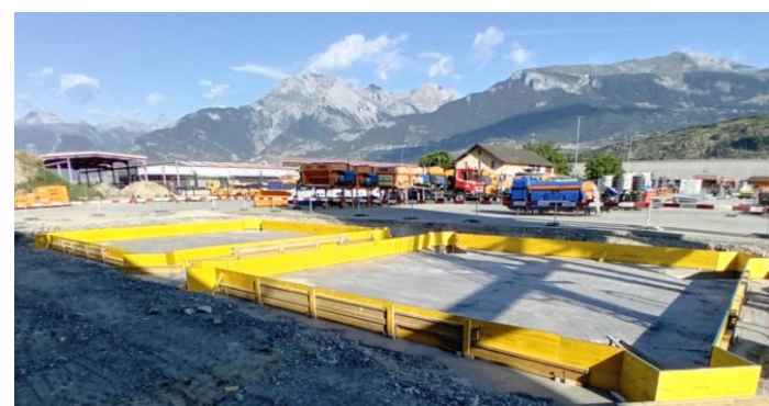
Réalisation des radiers
