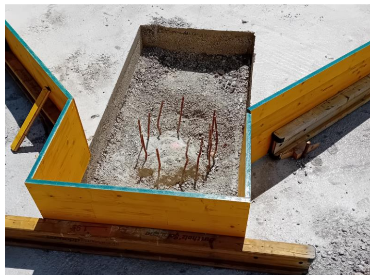
Recépage des pieux
