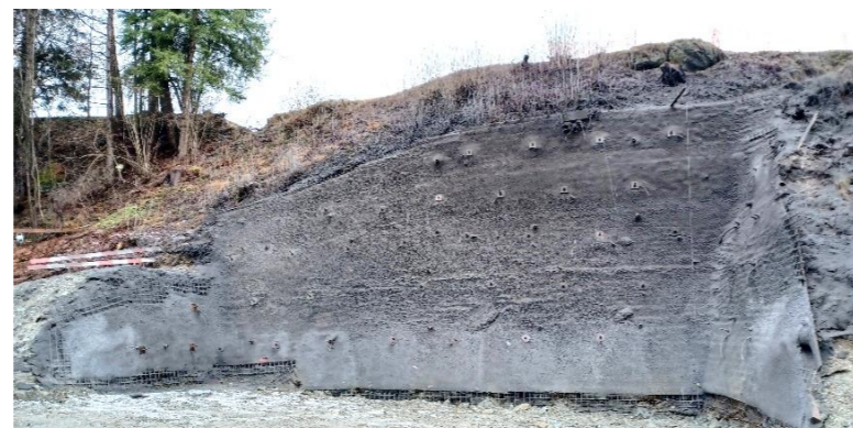
Paroi clouée – Station aval
