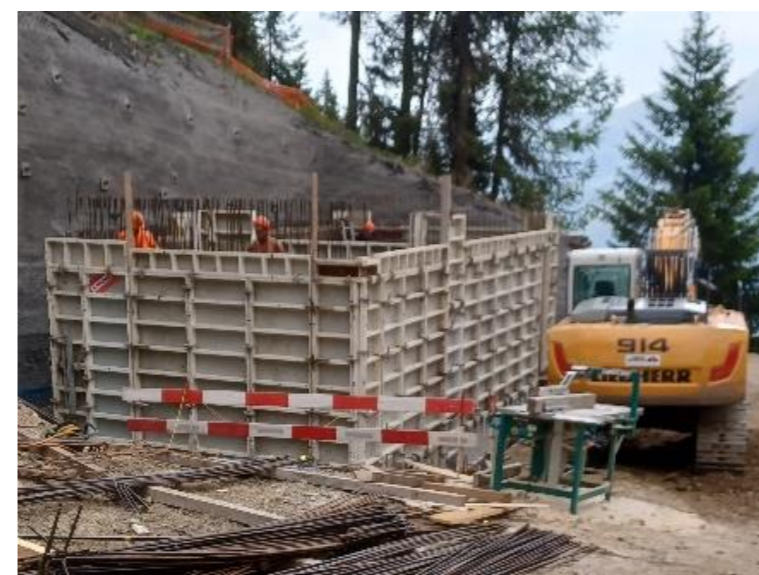
Coffrage des murs – Station amont
