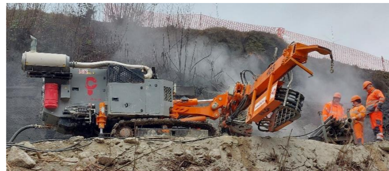
Réalisation des ancrages – Station aval
