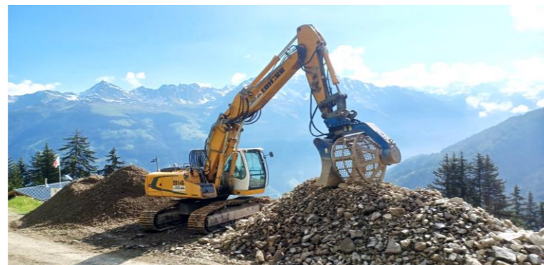
Criblage des matériaux d'excavation – Station amont
