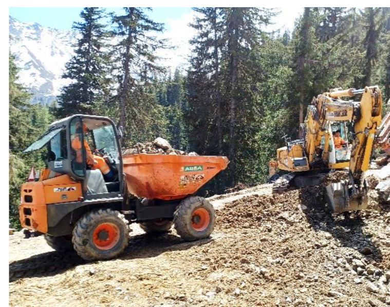
Travaux de terrassement – Station amont
