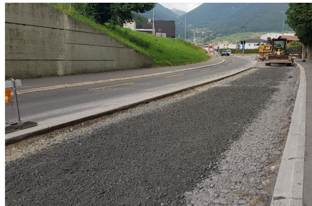
Planie et réfection des enrobés bitumineux
