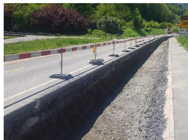
Fouilles pour la pose des conduites
