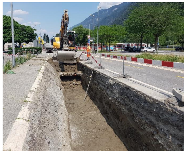
Excavation en tranchées
