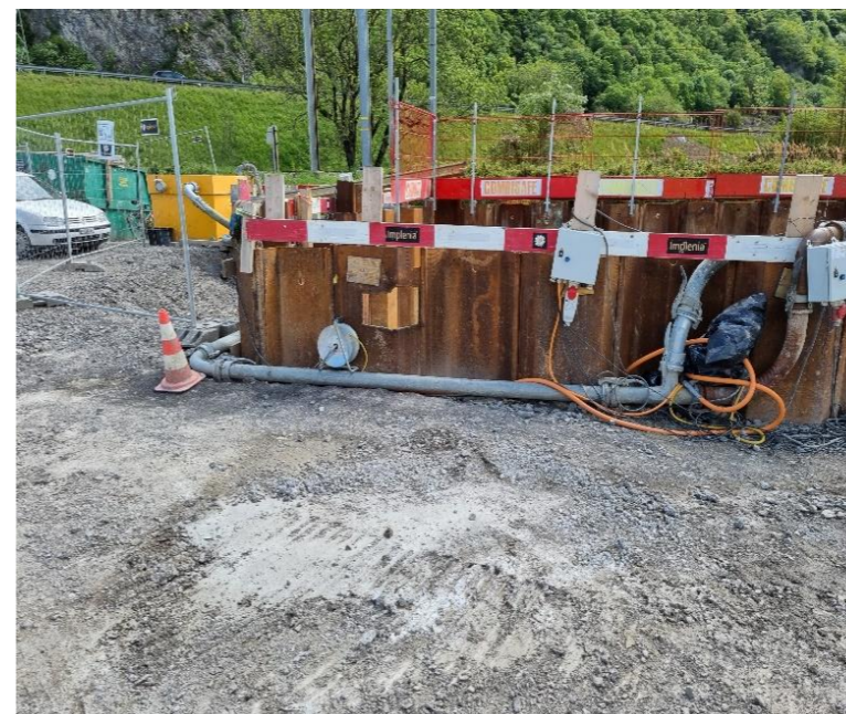
Rabattement de nappe phréatique : création de puits filtrants et mise en place de pompes submersibles
