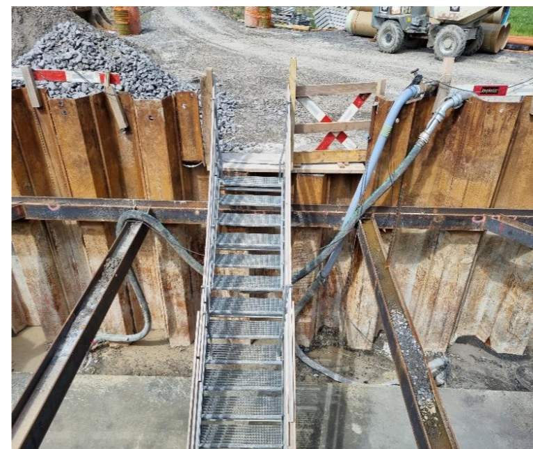
Rabattement de nappe phréatique : création de puits filtrants et mise en place de pompes submersibles
