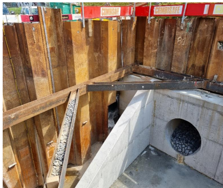
Palplanches et butons de renforcement pour enceinte de fouille
