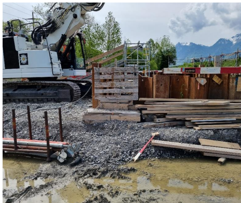
Rabattement de nappe phréatique : création de puits filtrants et mise en place de pompes submersibles
