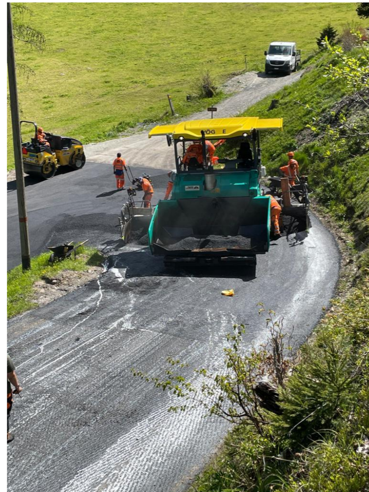
Poses des couches de reprofilage et de base sur enrobés existants fraisés
