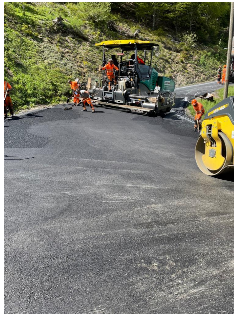
Pose du revêtement final – couche de roulement
