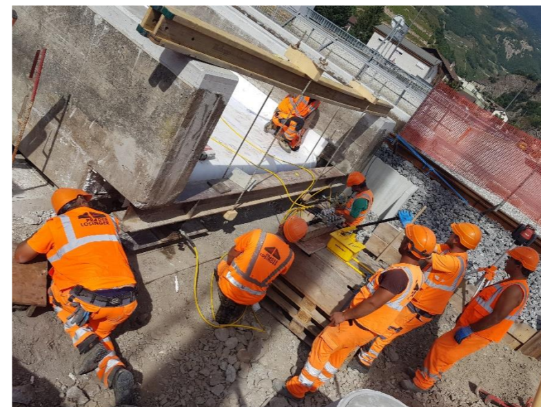
Ripage du pont
