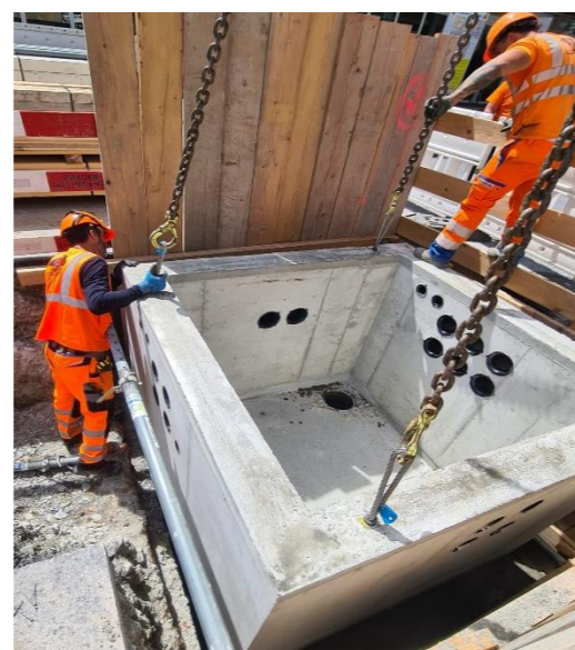
Préfabrication et pose de chambres Oiken
