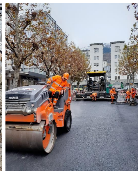
Couche de base et tapis bitumineux
