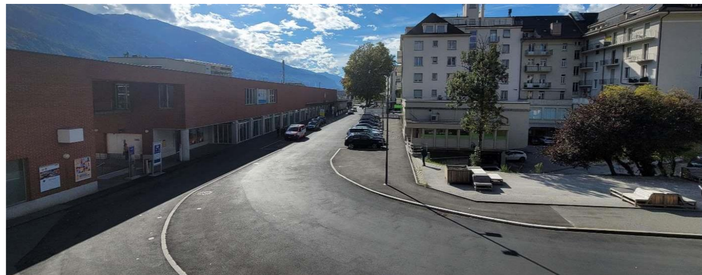
Esplanade de la Gare et Rue Centrale Sud – État fini
