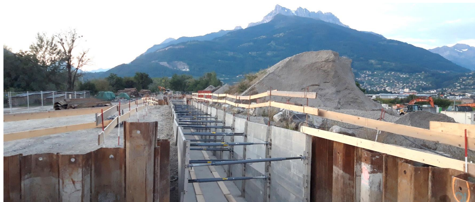
Lot 2 - Fouille principale en U, palplanches et blindage de fouilles (aluminium)
