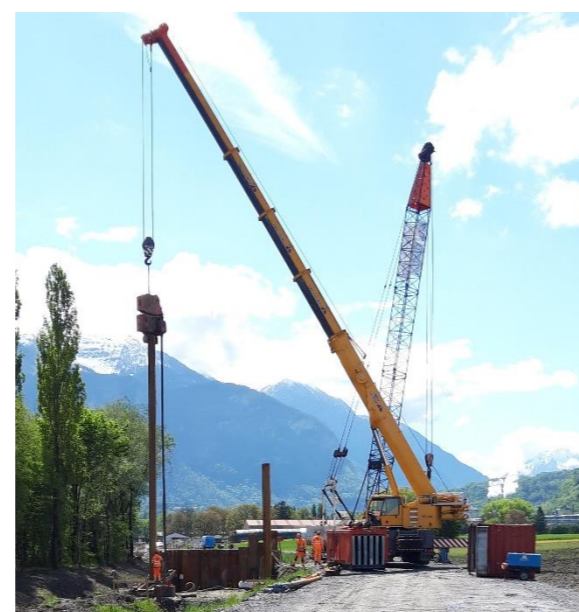
Lot 3 – Travaux spéciaux
