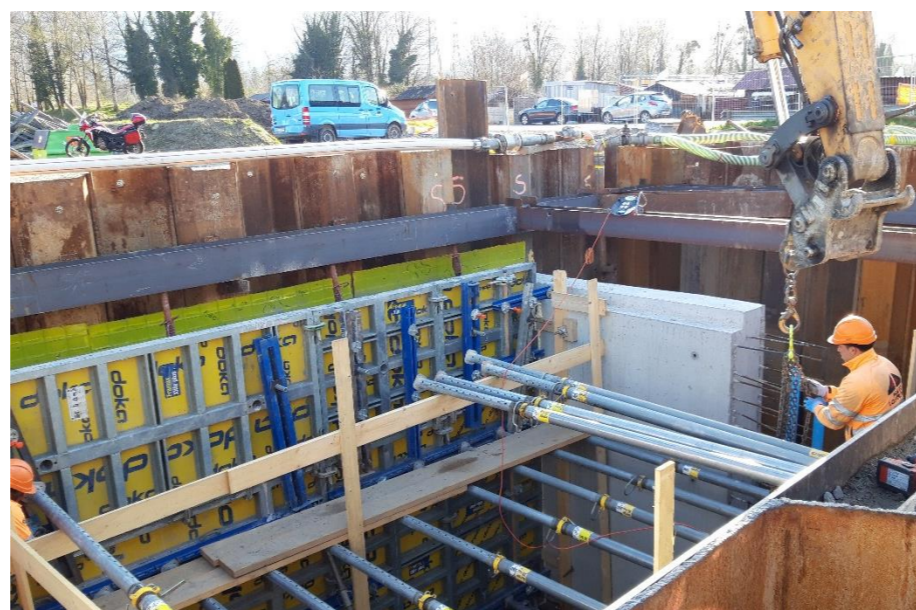
Lot 3 – Travaux béton armé
