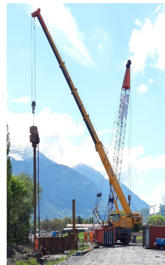
Lot 3 – Travaux spéciaux
