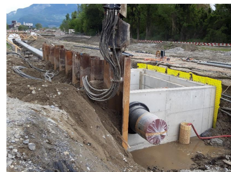
Lot 3 - Cellules de palplanches pour les chambres en béton armé
