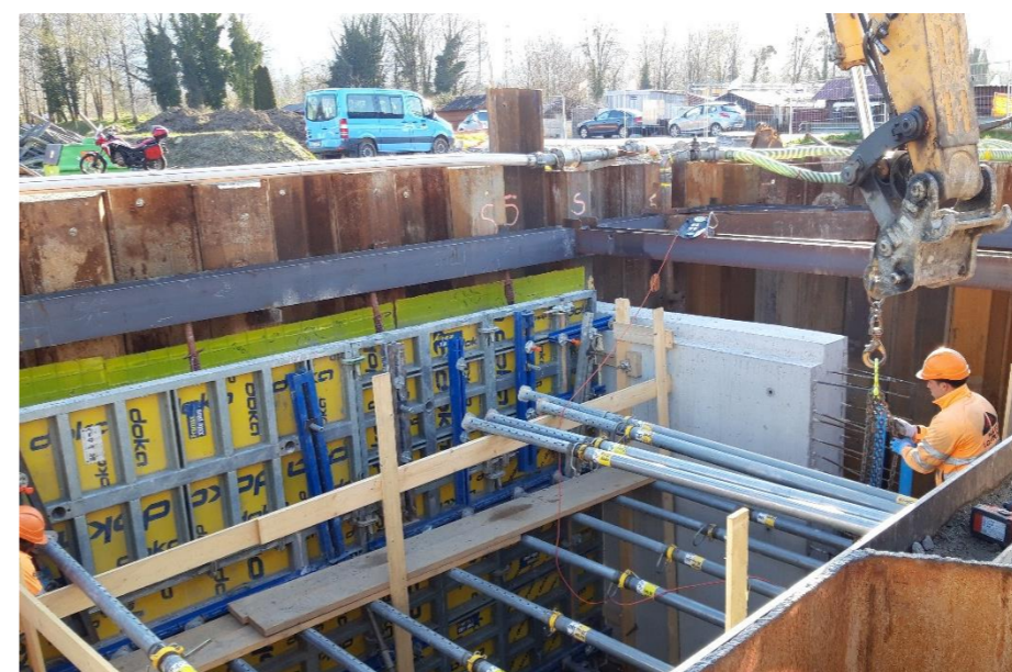
Lot 3 – Travaux béton armé
