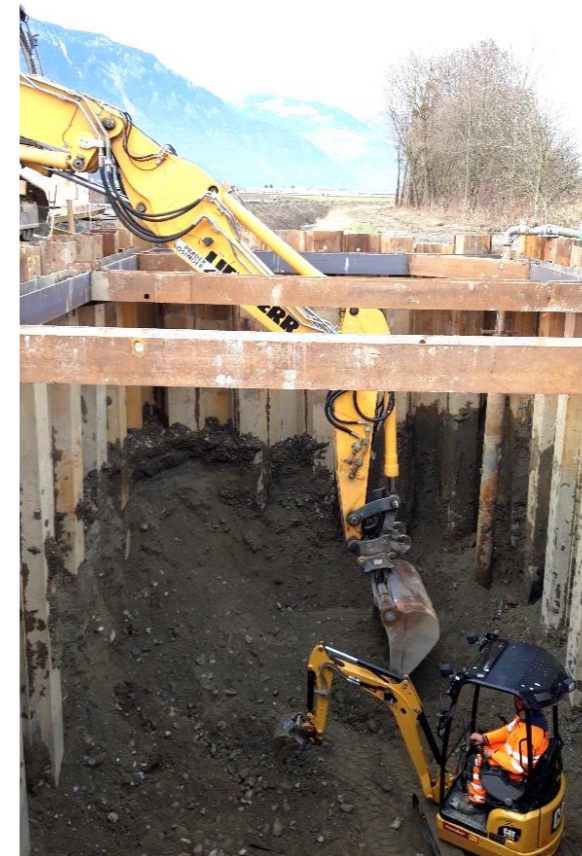
Lot 3 – Excavation dans les enceintes
