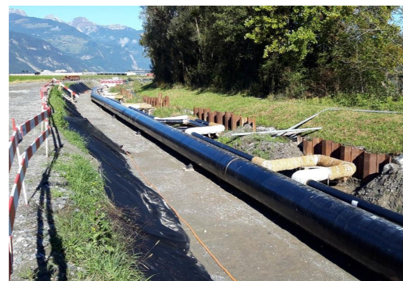
Lot 3 - Fouille principale en V, tuyaux vapeur et condensat
