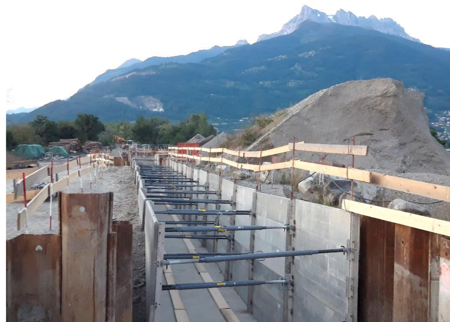
Lot 2 - Fouille principale en U, palplanches et blindage de fouilles (aluminium)
