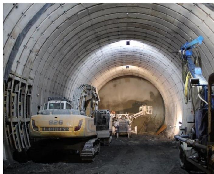
Montage des cintres et des corbeilles de ferraille pour le soutènement (en radier et en calotte)
