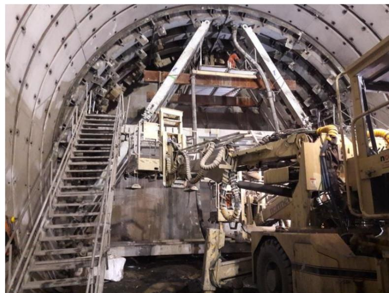
Bétonnage du soutènement en calotte
