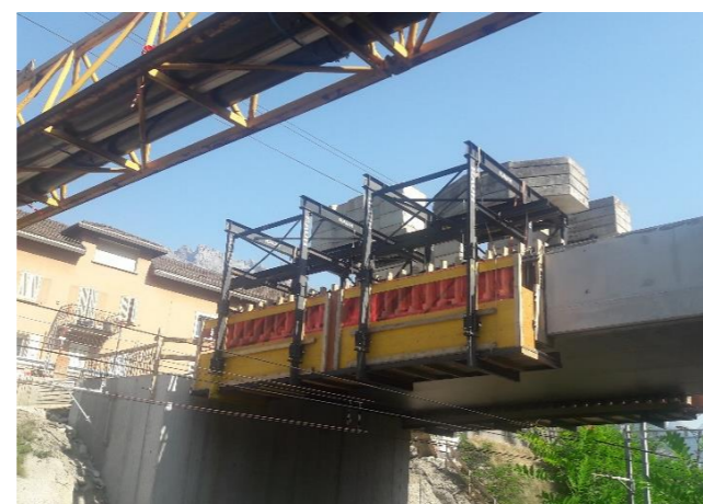
Parapets réalisés avec chariot ripplable
