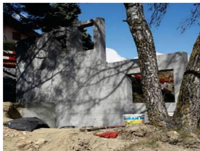
Ouvrages en béton armé apparent
