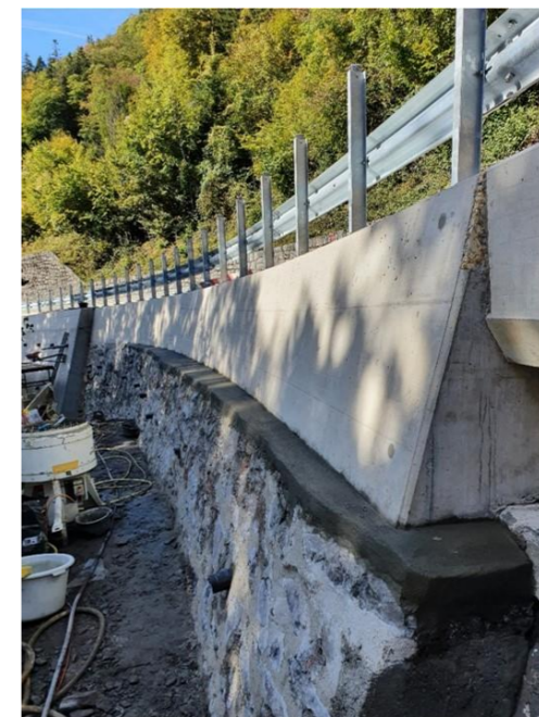
Nouvelle bordure après décoffrage
