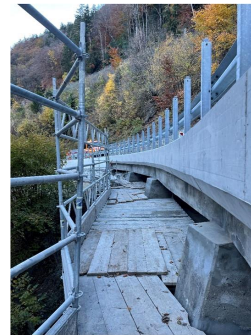
Pont - Nouvelle bordure après décoffrage
