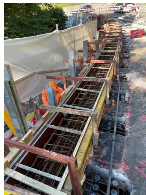
Pont – Nouvelle bordure
