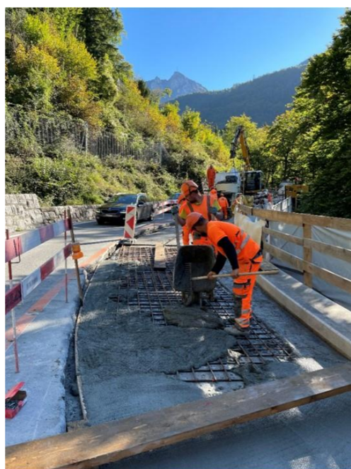
Pont – Tablier en béton BFUP
