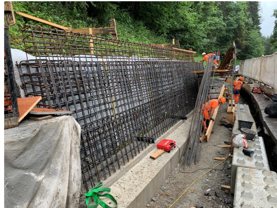
Mur 107 – Paroi clouée, natte drainante et ferrailage
