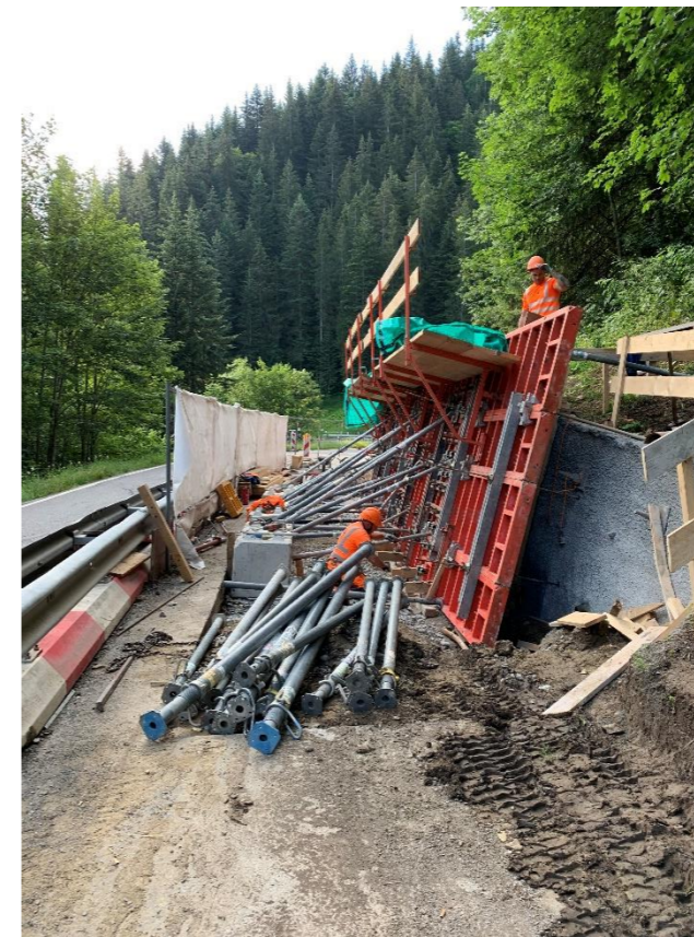
Mur 107 – Coffrage 1 face avec fruit
