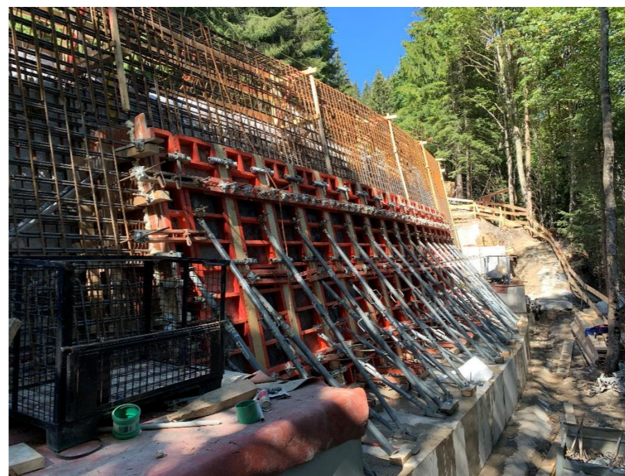
Mur 104 – Coffrage 1 face grande hauteur avec fruit
