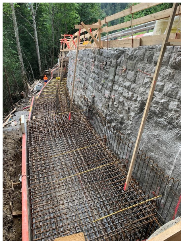
Mur 104 – Semelle en béton armé
