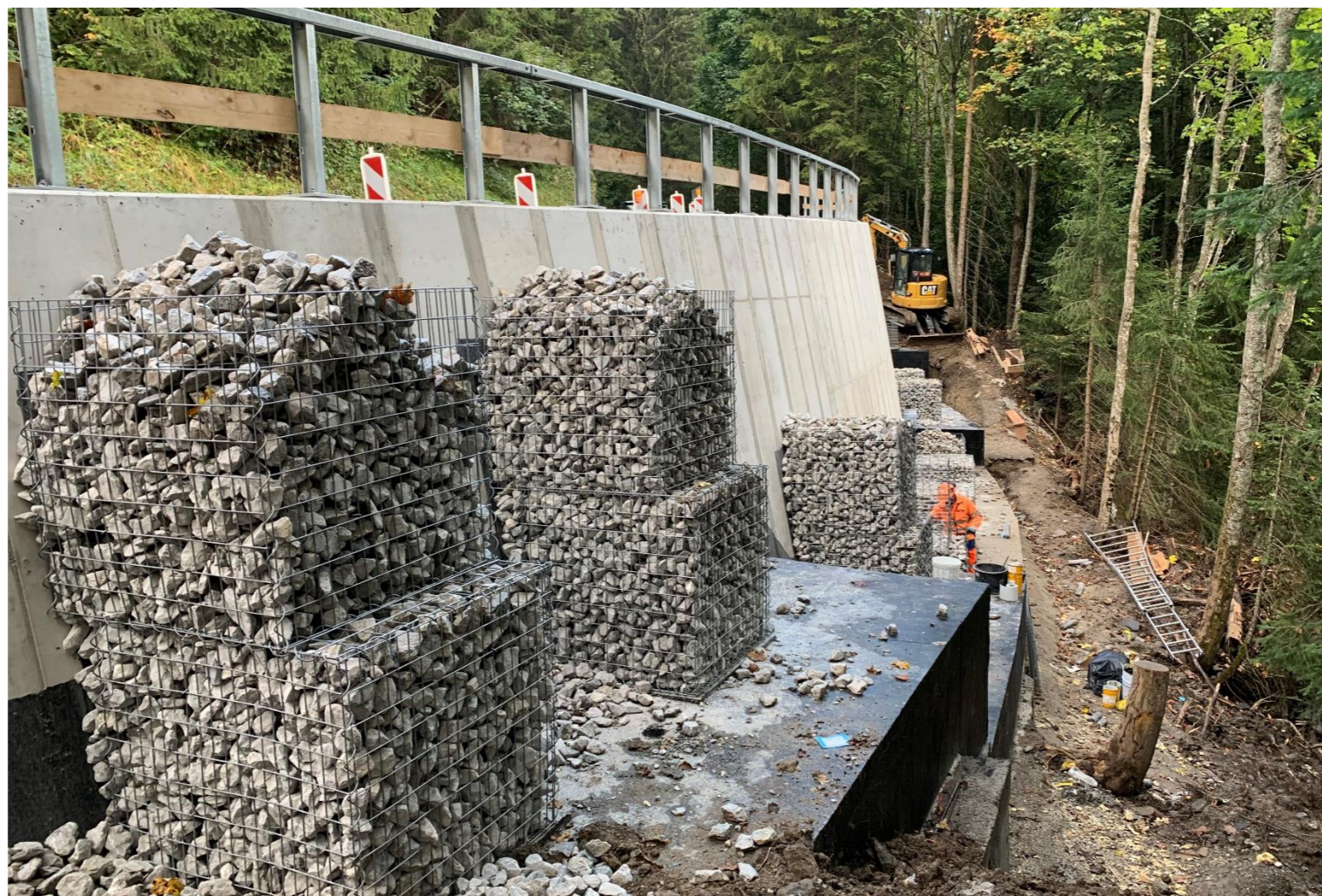
Mur 104 – Réalisation des gabions, remblayage, mise en place des glissières et pose des enrobés
