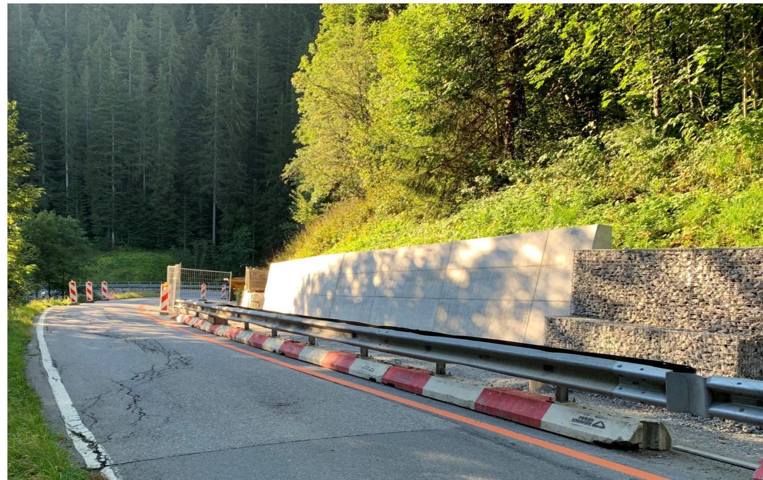
Mur 107 – Réalisation des gabions, remblayage et pose des enrobés
