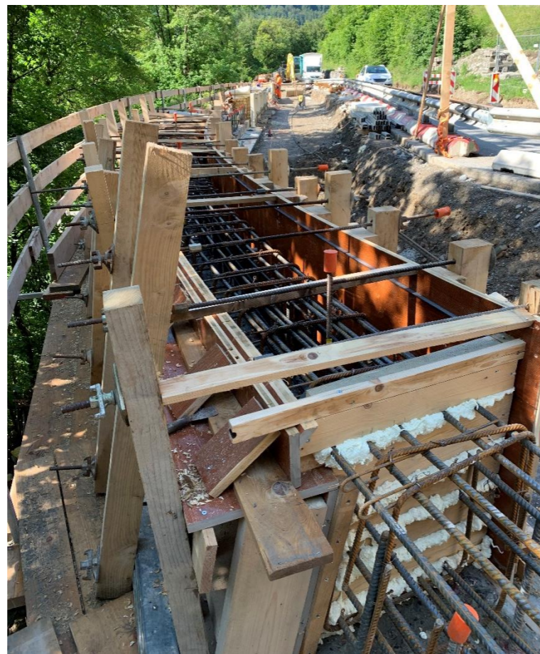
Mur 298 - Nouvelle bordure en béton armé
