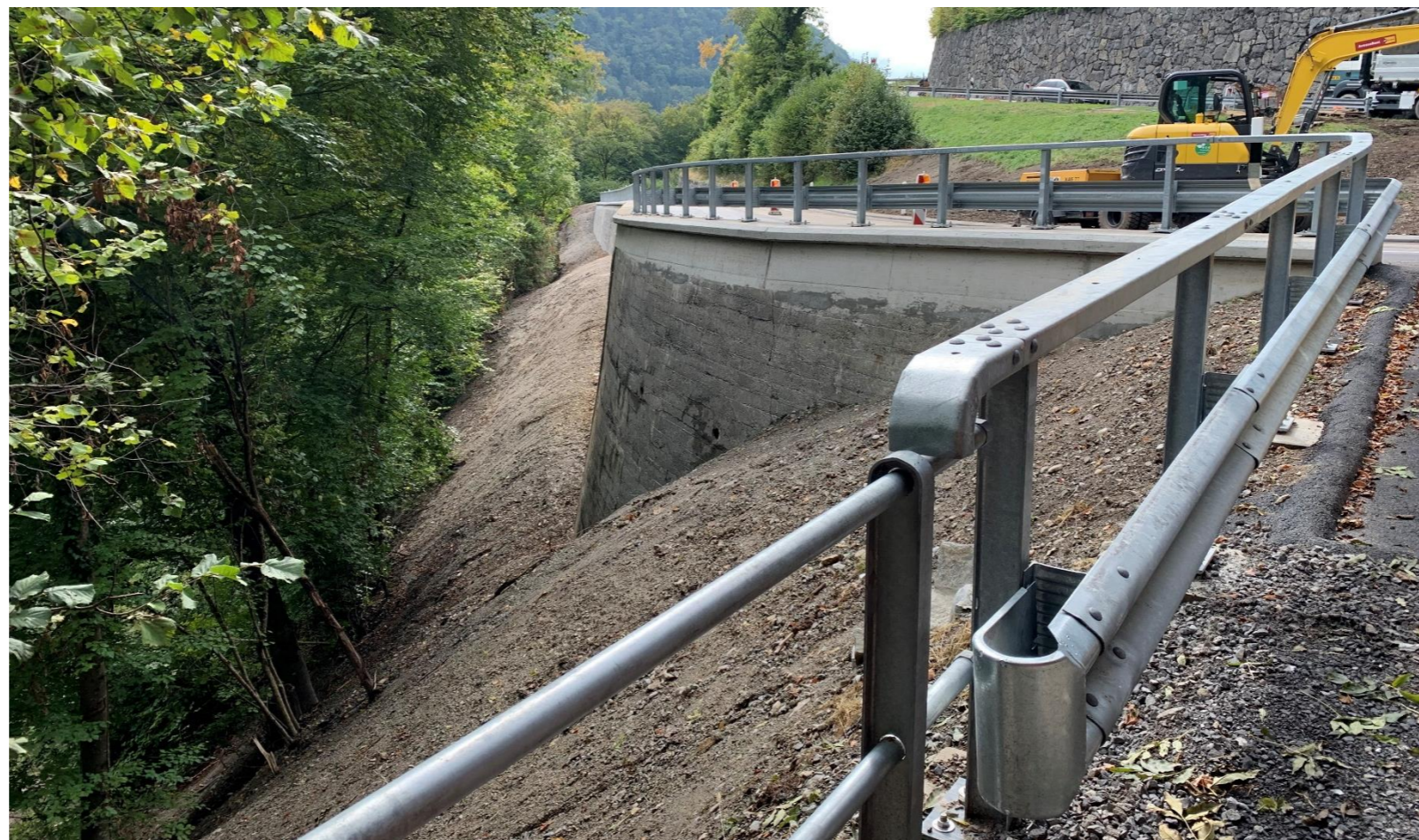
Mur 298 – Remblayage, mise en place des nouvelles glissières et pose des enrobés
