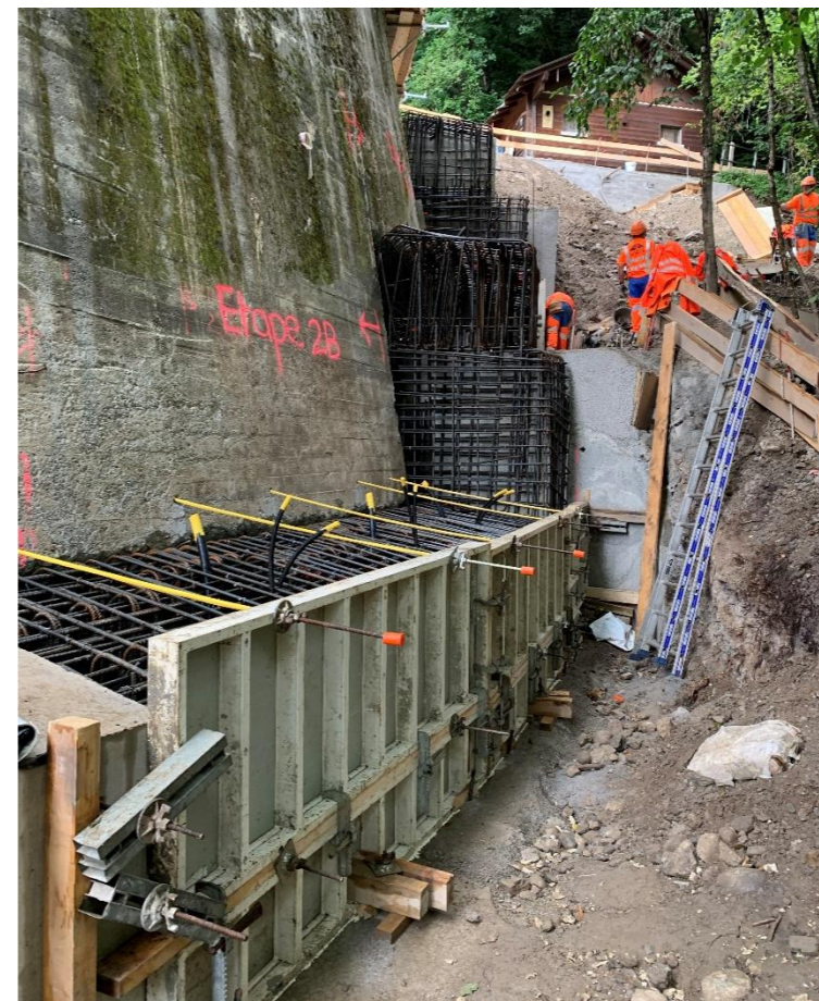
Mur 298 - Nouvelle fondation sur micropieux
