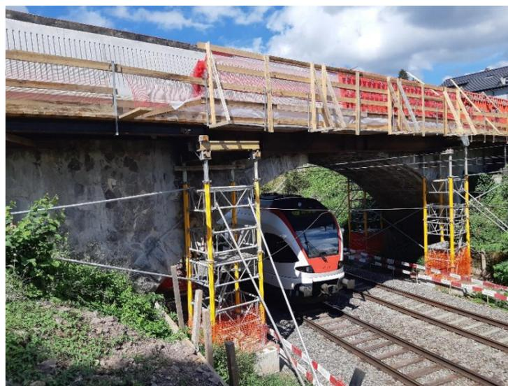
Plateforme de travail au-dessus des voies
