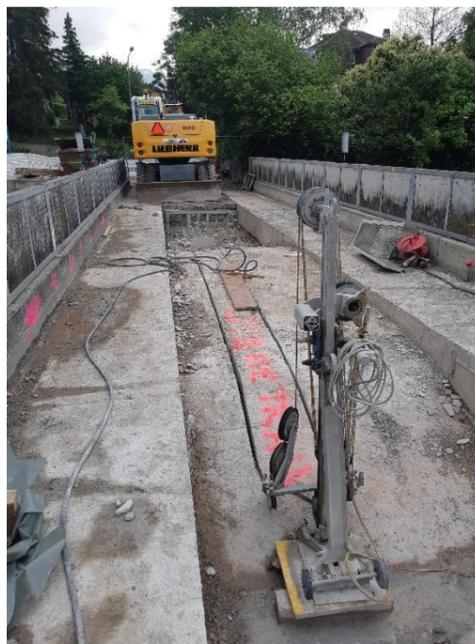
Sciage de la voûte en maçonnerie (saignée)
