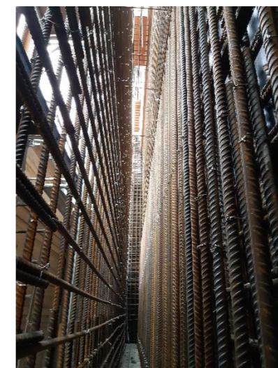
Ferrailage mur de culée (h = 9m)
