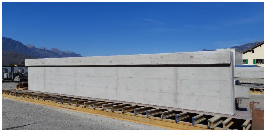
Préfabrication des parapets du pont
