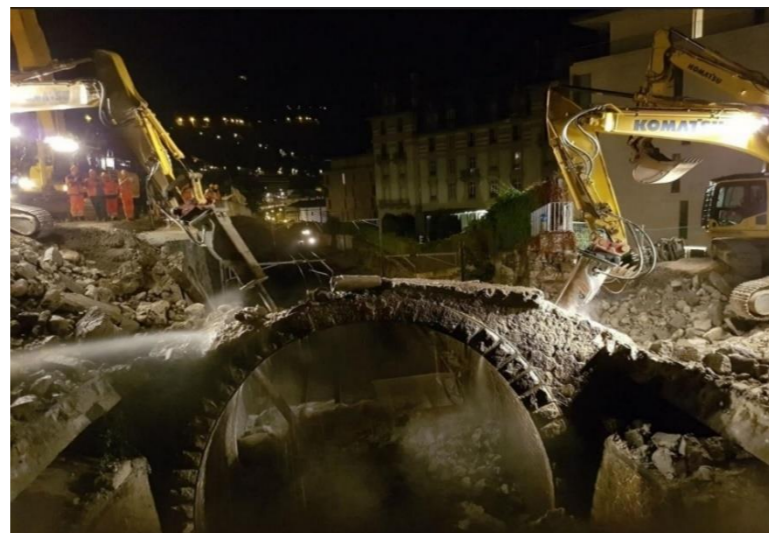
Démolition du pont – opération coup de poing (une nuit)
