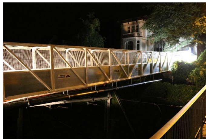
Passerelle piéton (fabrication et montage PL)
