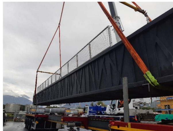
Chargement passerelle préfa BFUP
