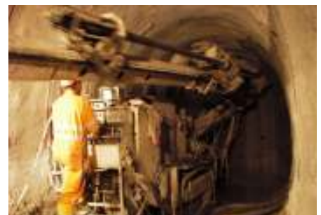
Soutènement : Jetting dans les galeries de pied
