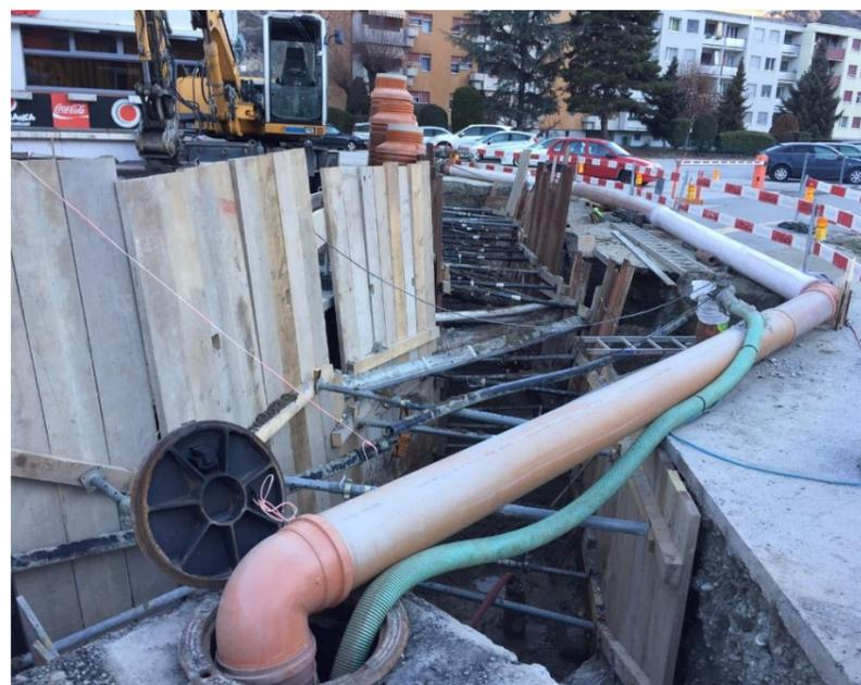
Pompage de la nappe avec système de puits battus
