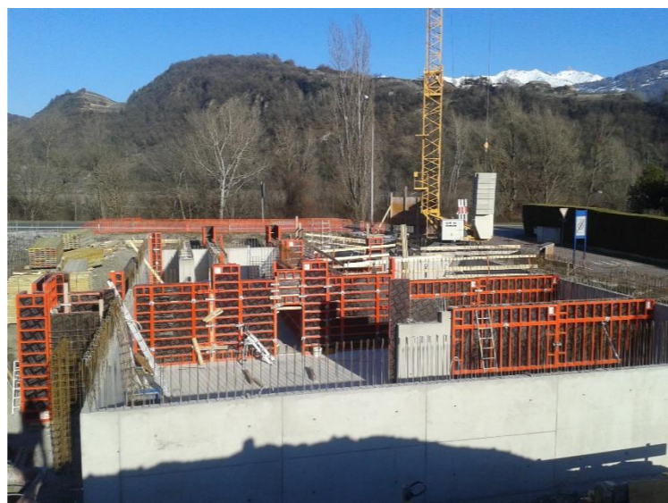
Coffrage murs rez
