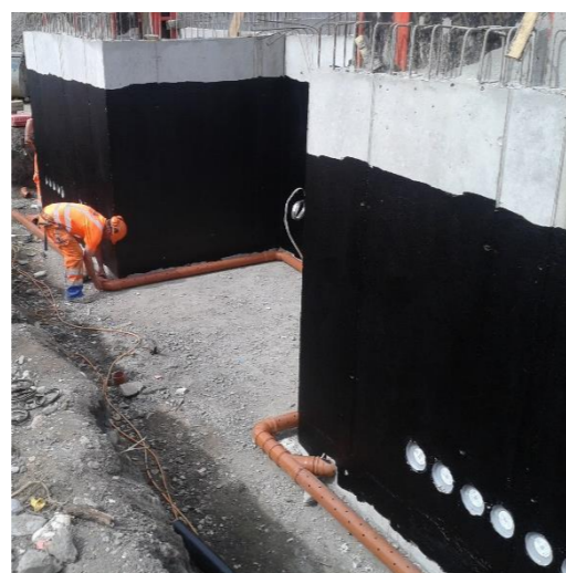
Pose du drainage
