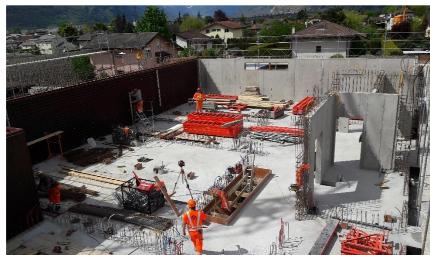
Armature murs étage
