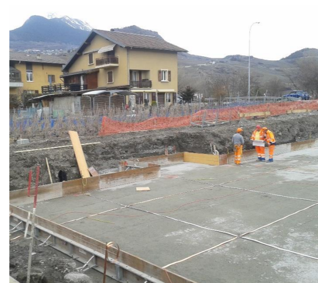
Mise à terre sur béton maigre
