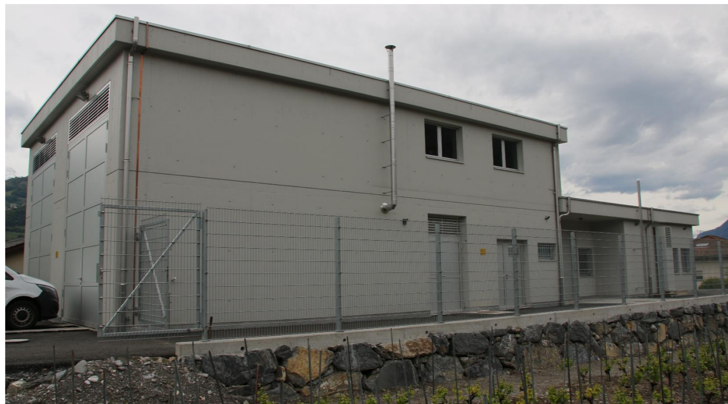
Situation Final avec les aménagements extérieur
