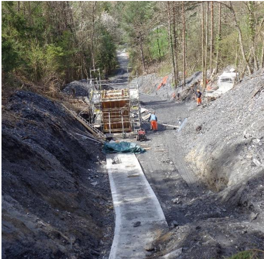
Coffrage cheminée d'accès
