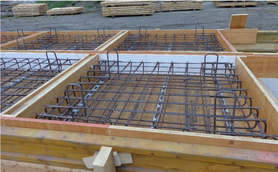
Préfabrifications des dalles de couverture
