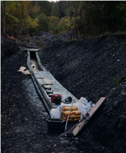
Couverture dalle préfa
