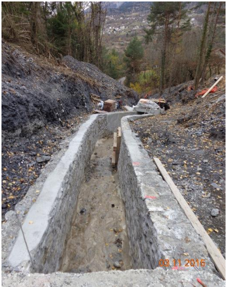
Réfection murs d'ailes
