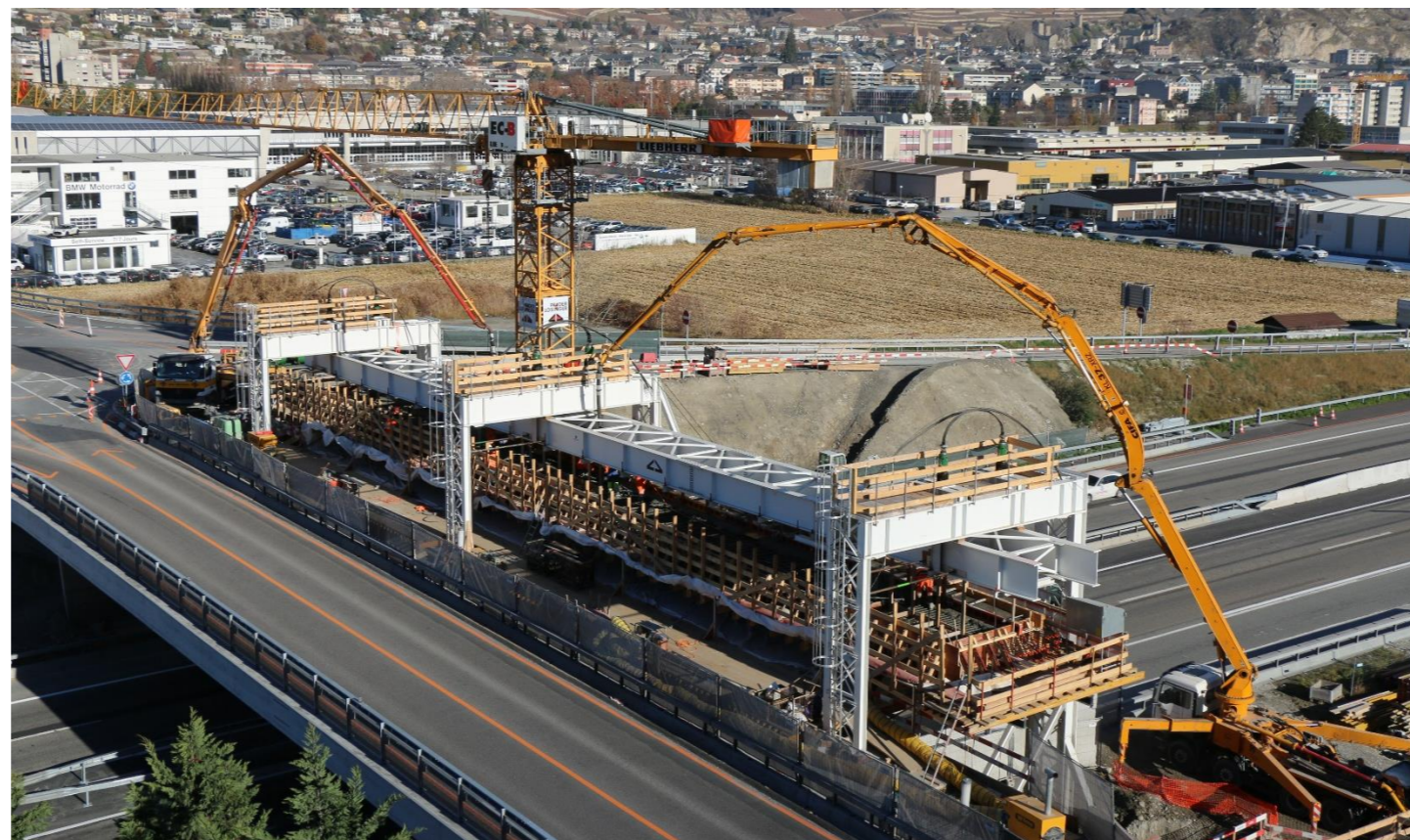
Situation général, bétonnage du tablier est
