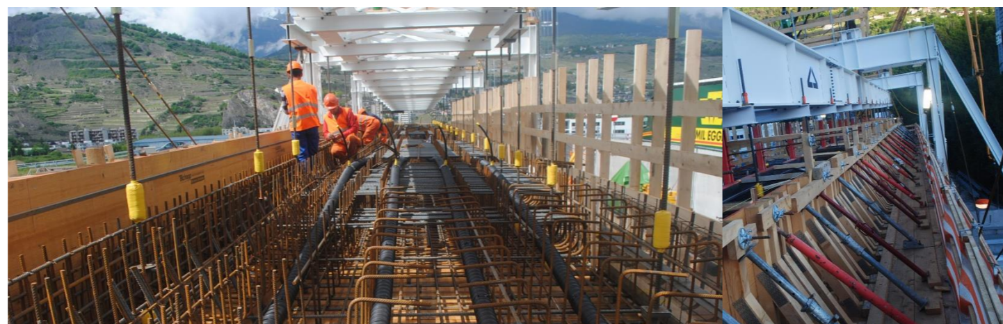
Coffrage de bord du tablier
