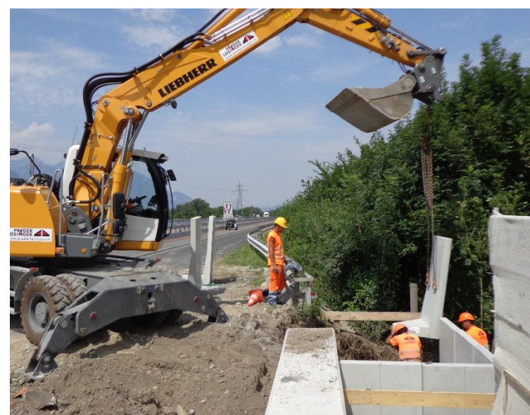
Chambre élec. avec pose d'élément préfabriqué
