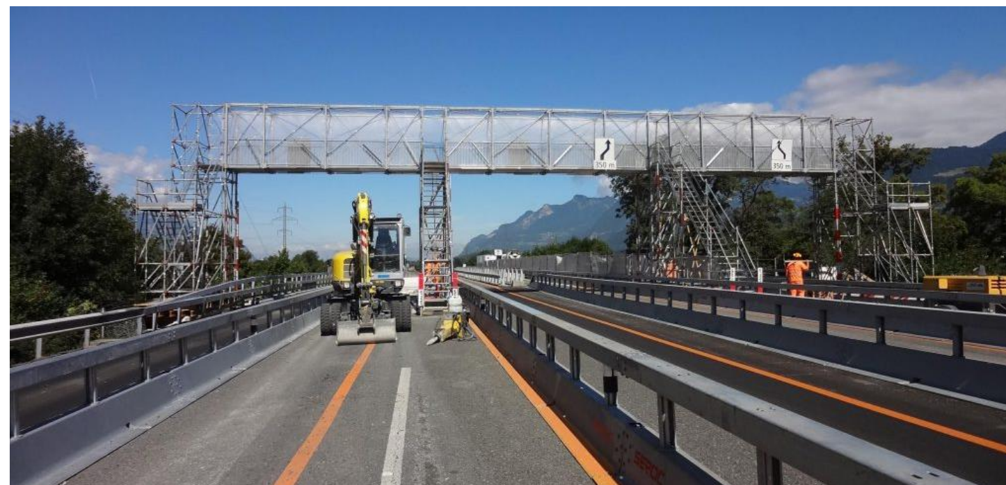
Déviation de la circulation et passerelle piéton pour ouvriers
