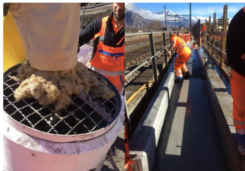
BFUP, béton fibrés
